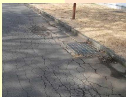
道路の沈下によるひび割れ
