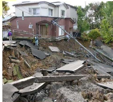
盛土の滑動崩落による宅地被害
