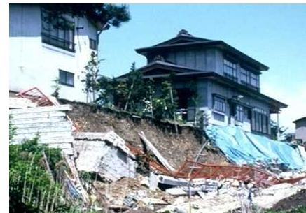
擁壁の倒壊による宅地被害の事例
